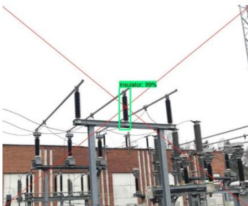
Результат определения источника ЧР
